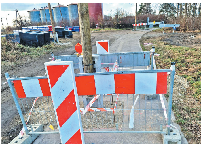
Prace na ulicy Węglowej trwają. Aktualnie montowane są słupy telekomunikacyjne.
