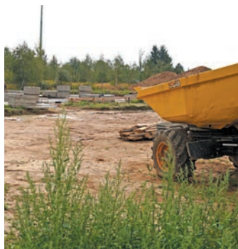
Prace budowlane już się rozpoczęły.
