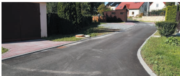
Droga zyskała nową nawierzchnię, a zjazdy do posesji wyłożono betonową kostką.
