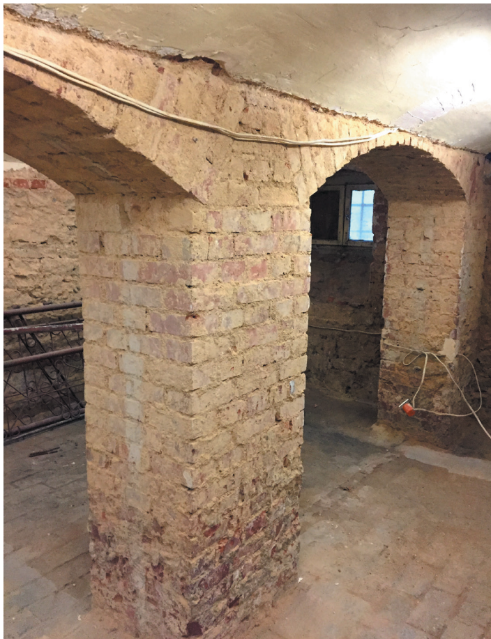
Remont piwnic w obiekcie szkoły rozpoczął się w 2017 roku. Dziś pomieszczenia są nie do poznania.
