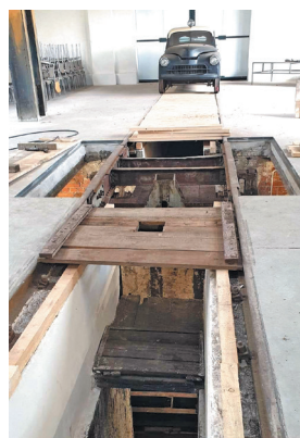
◀▲ Suwnia umożliwia podnoszenie ciężkich parowozów, zapadnia – demontaż zestawów kołowych. Po remoncie oba obiekty odzyskały dawną funkcjonalność.
