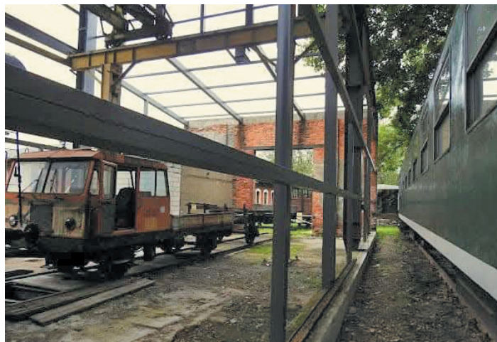
Zapadnia i suwnia umożliwiają naprawę parowozów. Na zdjęciu przed rozpoczęciem prac.
