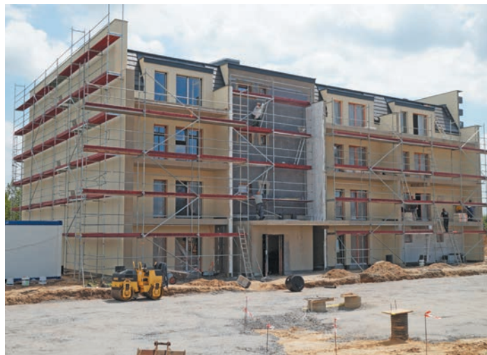
Obecnie w budynku przy ul. Ekerta prowadzone są prace elewacyjne.
