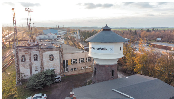
Wieża ciśnień zyskała właśnie nowe oblicze. Kolejnym etapem będzie rewitalizacja dawnego budynku administracji Wagonowni.
