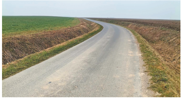
Wzdłuż ulicy Świdnickiej wyczyszczono rów odwadniający o długości 2,3 kilometra po obu stronach.
