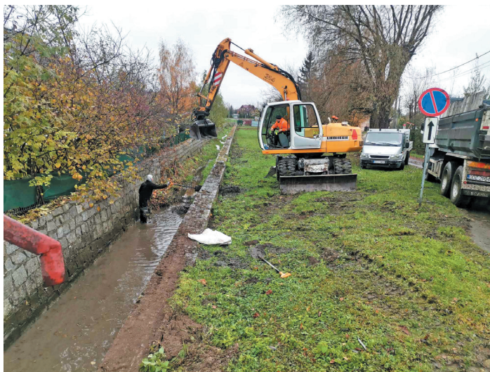
Rozpoczęło się oczyszczanie Milikówki.
