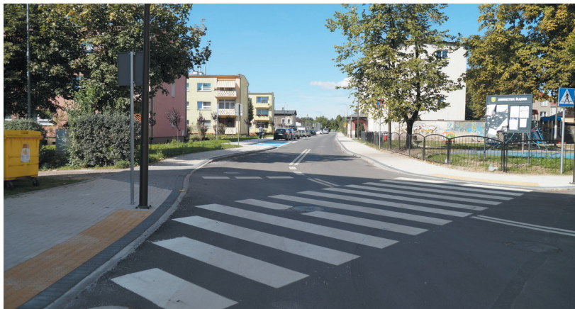
Prace na ulicy Ceglanej zostały zakończone.
