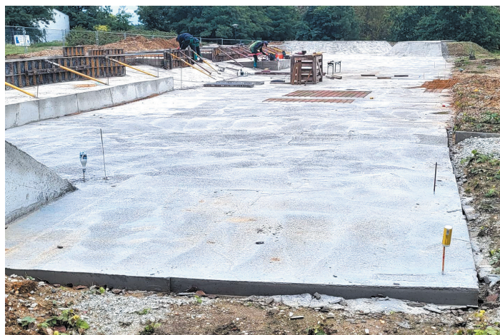
Na terenie żwirowni w ramach kompleksu rekreacyjno-sportowego powstaje m.in. skate park.
