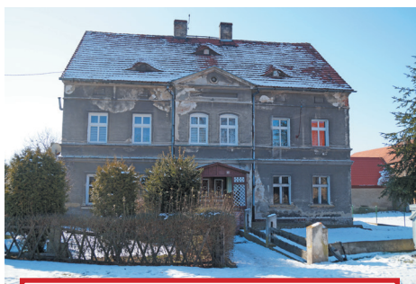
Wspólnota Mieszkaniowa Piotrowice Świdnickie 17 - wymianę pokrycia dachowego, remont elewacji, naprawę schodów granitowych, docieplenie poddasza i stropu piwnicy, wymianę stolarki okiennej i drzwiowej. Wartość projektu 488 497,97 zł, dofinansowanie 390 798,38 zł
