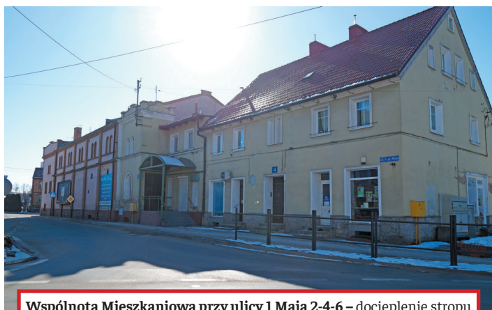
Wspólnota Mieszkaniowa przy ulicy 1 Maja 2-4-6 – docieplenie stropu piwnicy, stropodachu, remont elewacji, remont posadzek i schodów. Wartość projektu 479 954,68 zł, dofinansowanie 365 615,09 zł
