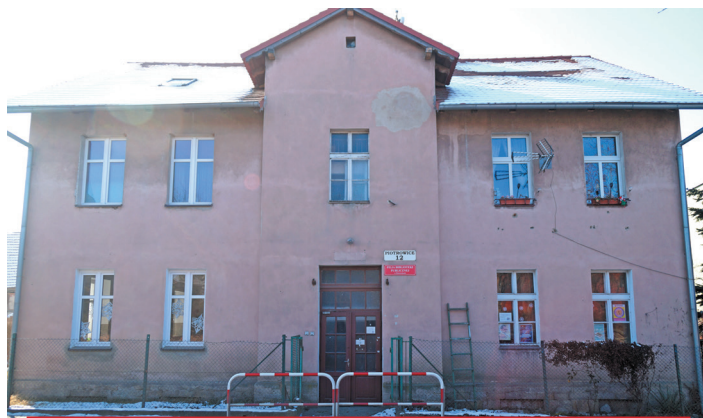
Wspólnota Mieszkaniowa Piotrowice Świdnickie 12 – remont pokrycia dachowego, remont elewacji, wymianę stolarki okiennej i drzwiowej. Wartość projektu 571 182,97 zł, dofinansowanie 299 658,74 zł
