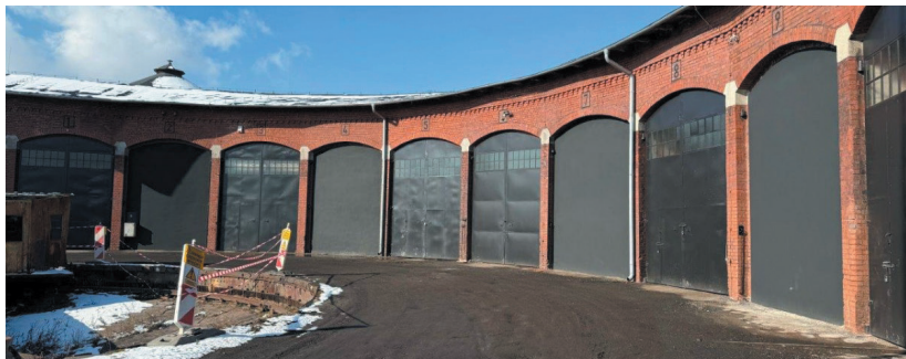
Remont elewacji hali wachlarzowej dobiegł końca.
