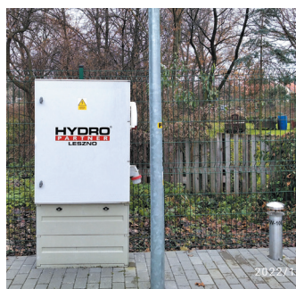
Wybudowano i uruchomiono także tłocznię ścieków.
