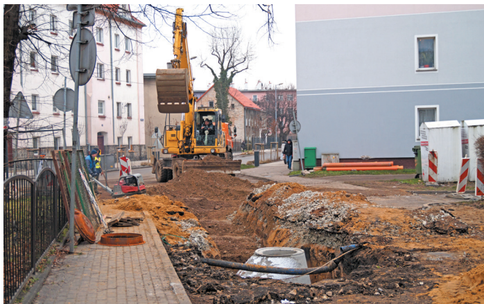
Rozpoczęły się prace związane z budową kanalizacji deszczowej.
