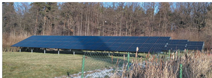
Wybudowano dwie instalacje fotowoltaiczne o mocy 49,59 kW każda.
