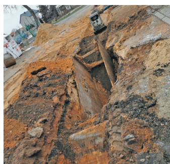
W ramach inwestycji wykonano 7,47 km sieci kanalizacji sanitarnej w Pastuchowie, m.in. przy ul. Kolejowej.
