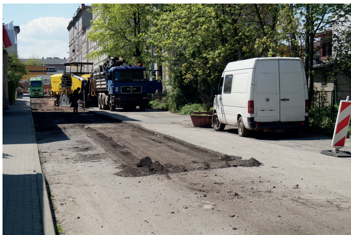
Sfrezowano już nawierzchnię ulicy i rozpoczęto budowę infrastruktury podziemnej.
