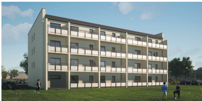
W budowanym obiekcie znajdzie się 30 mieszkań.
