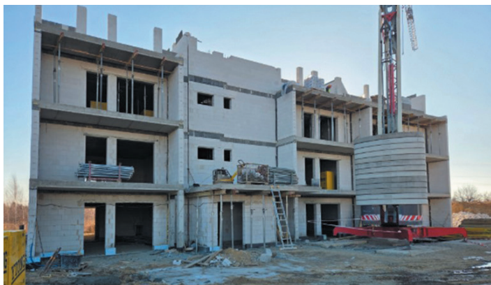
Prace budowlane trwają. Planowany termin oddania mieszkań najemcom to pierwszy kwartał 2027 r.
