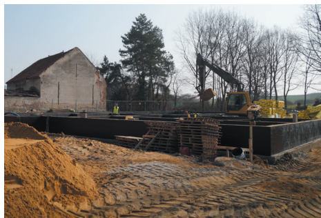
W Milikowicach widoczne są już fundamenty nowej świetlicy.
