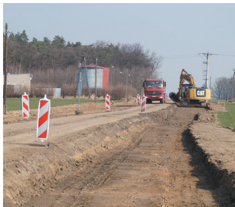
Trwają prace związane z budową sieci kanalizacyjnej i wodociągowej.
