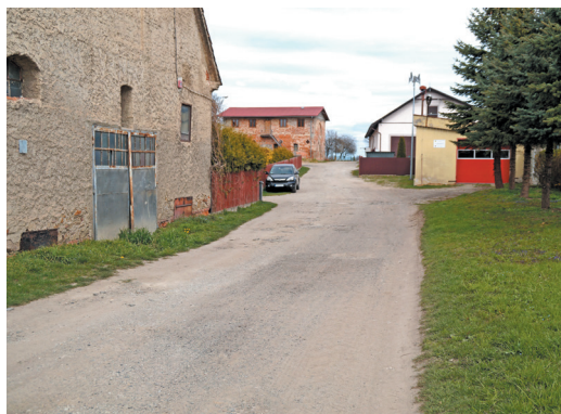
Wybudowana zostanie także droga obok siedziby ochotniczej straży pożarnej.
