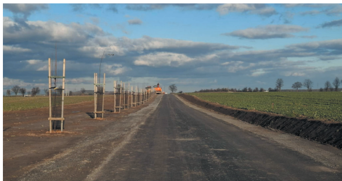
Nowo budowana droga połączy się z tą oddaną do użytku w ubiegłym roku.
