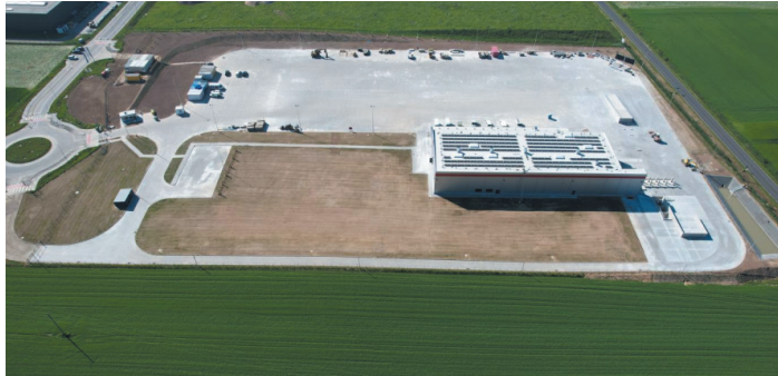
Budowa zakładu produkcyjnego dobiega końca. Produkcja powinna ruszyć jeszcze w tym roku.
